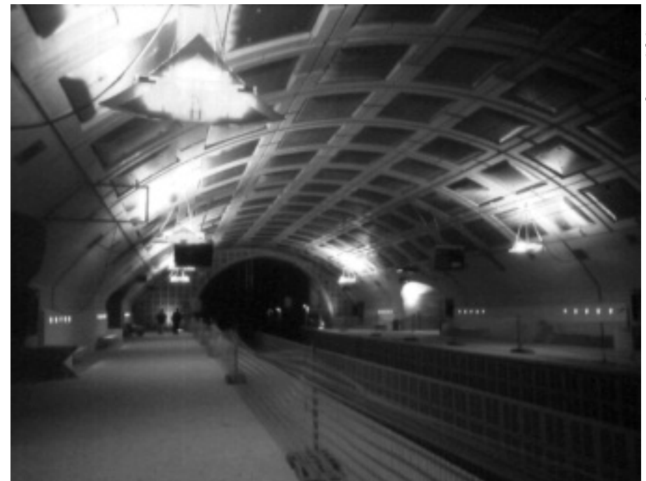
La voûte de la station Magenta, 1999
