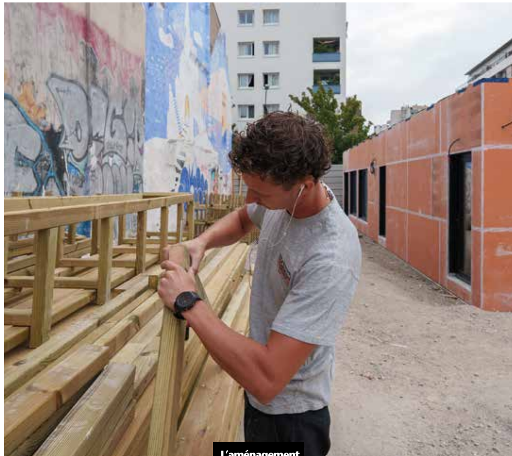
L'aménagement de la parcelle du 49-53, rue des Sept-Arpens bat actuellement son plein.
