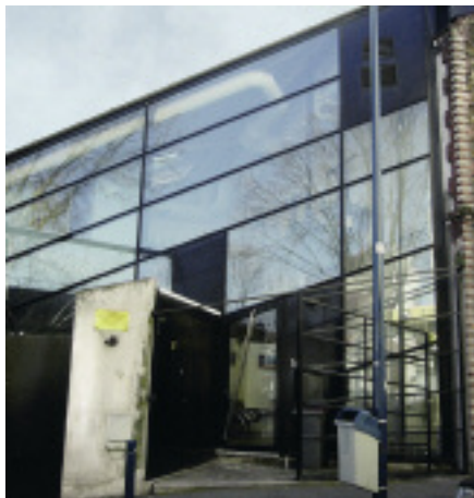
Vue actuelle de l'extérieur du CMP sur la rue Lépine.
