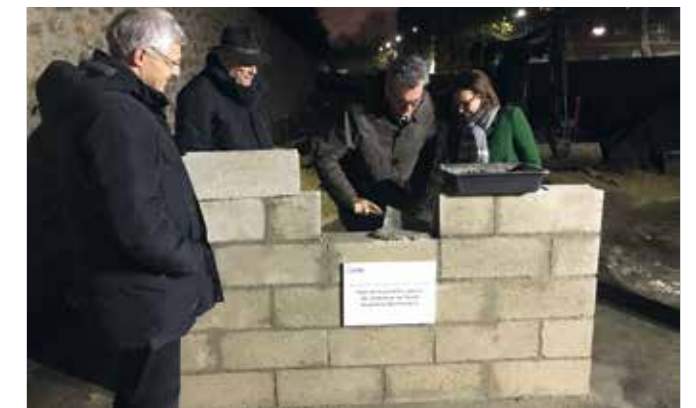
Vendredi 29 novembre, la première pierre de l'extension de l'école Quatremaire a été posée. À la rentrée 2020, les enfants scolarisés dans cet établissement situé aux Courtilières découvriront un nouveau bâtiment qui abritera une salle de classe et un réfectoire . Un jardin pédagogique complétera l'ensemble.
